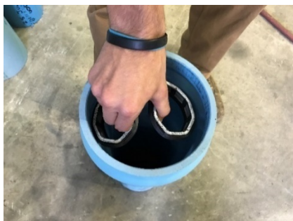
Formant une boucle pour insérer des RieberLok joint dans la rainure sec
