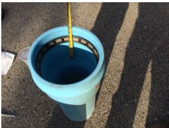
Mesurer la distance entre le rebord de la cloche et la fin de la prise.
