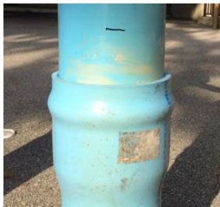
Robinet a marqué avec la raie de l'Assemblée avant l'insertion
