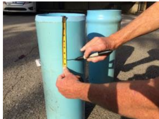
Placer la marque de l'Assemblée sur le robinet
