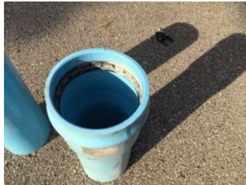
Application de lubrifiant à l'intérieur de la cloche
