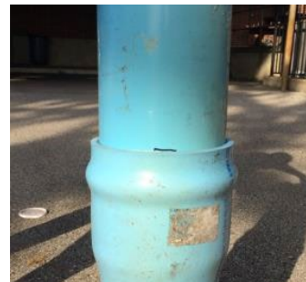
Pipe après installation remplie de RieberLok joint
